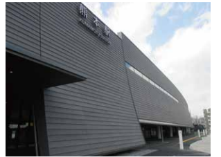
●熊本駅新駅舎
