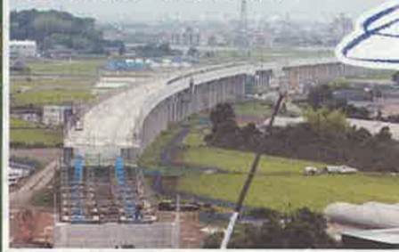
進む高架橋工事(宇土市)
