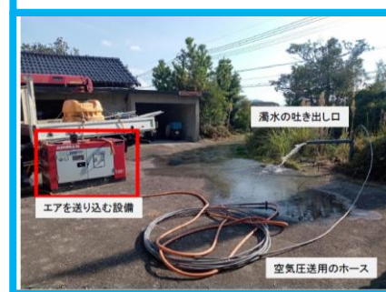
井戸の洗浄作業
