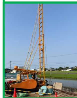
井戸の掘り直し作業
