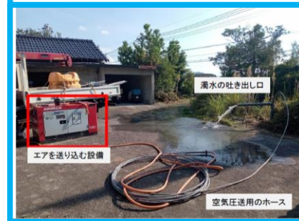
井戸の洗浄作業
