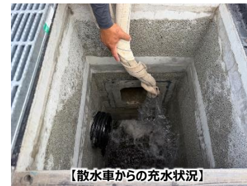
【散水車からの充水状況】
