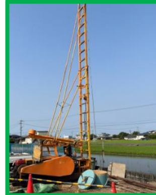
井戸の掘り直し作業
