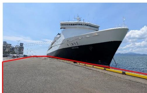
発災後も機能した耐震岸壁
