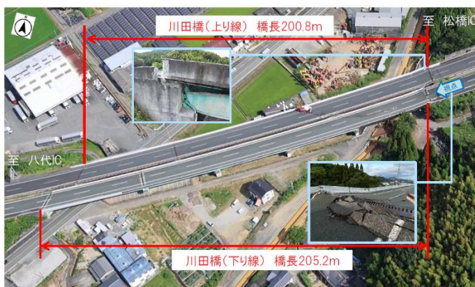
宇城氷川スマートＩＣ～八代ＩＣ（川田橋付近）
