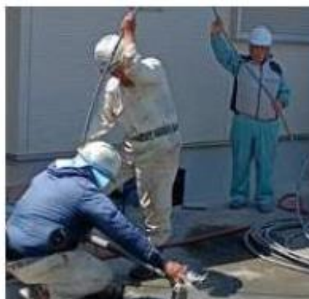
井戸復旧の様子
