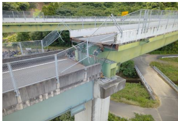
八代ＪＣＴ～八代南ＩＣ（妙見第一橋付近）
