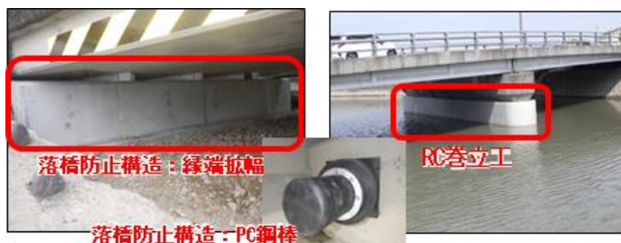
橋梁の耐震補強事例
