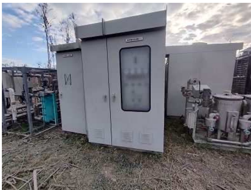
燃料電池撤去工事 2/4
