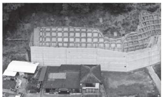
急傾斜地崩壊対策（山口地区：芦北町）
