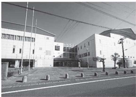
水俣市立総合体育館
