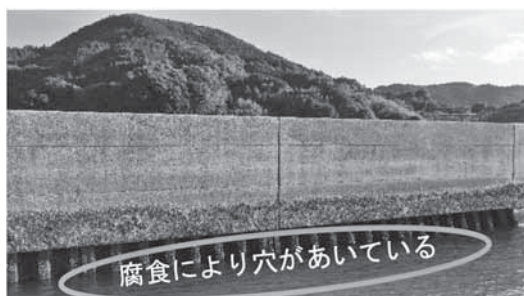
機能保全工事の実施【着工前】
