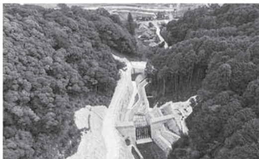
砂防（赤江川砂防えん堤：芦北町）
