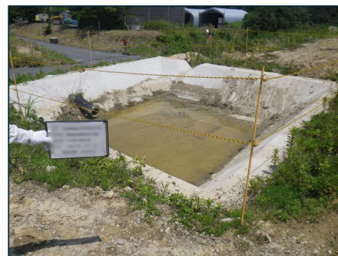
沈砂池設置例
