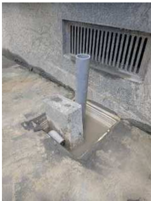
濁り水が発生した個人宅の井戸(八代市金剛地区)
