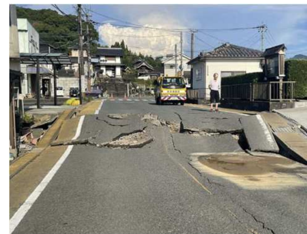
おがわかしま ▲小川嘉島線における舗装隆起 （宇城市）
