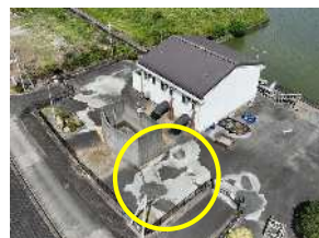
排水機場での液状化（八代市）
