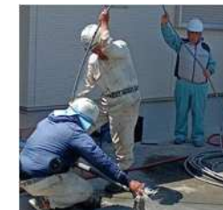
井戸の洗浄作業
