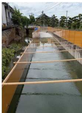
応急復旧後の通水状況
