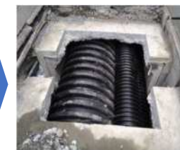
幹線水路の仮復旧状況
