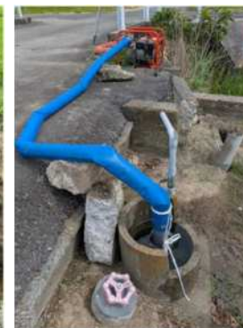
応急的な取水のための用水路の充水
