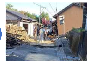
応急復旧に向けた倒壊家屋撤去
