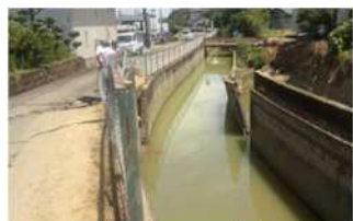
応急復旧後の試験通水
