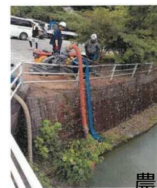
給水車用の応急取水ポンプ設置
