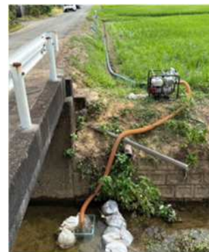
応急的な取水のための用水路の充水
