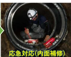
応急対応(内面補修)
