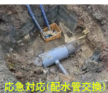
応急対応(配水管交換)
