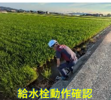
給水栓動作確認
