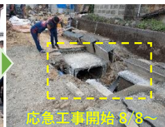
応急工事開始 8/8～
