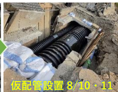
仮配管設置 8/10・11
