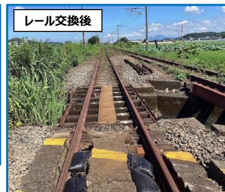
【松橋・小川間】損傷レール交換
