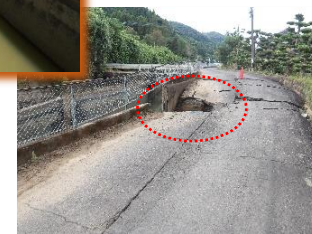
不知火幹線水路の 崩壊 (八代市)
