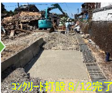
3割～4割復旧 8/12完了
