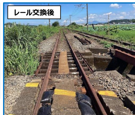
【松橋・小川間】損傷レール交換
