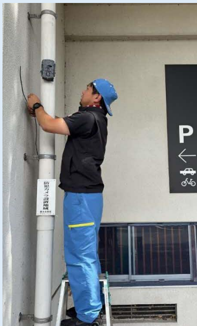
被災地への防犯カメラの設置
