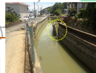
不知火幹線水路の 崩壊 (八代市)
