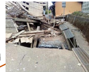
↑幹線用水路の沈下 (氷川町)
