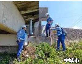
▼デジタル機器を用いた被災状況調査
