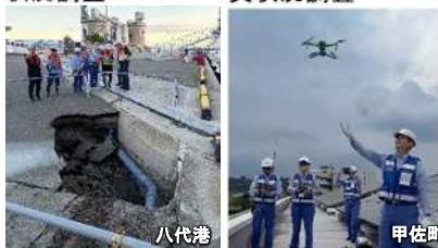
▼岸壁背後の被災状況調査
