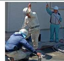
井戸の洗浄作業
