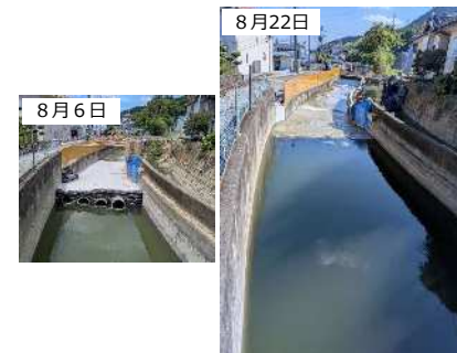
追加工事により送水量を増量（八代市）
