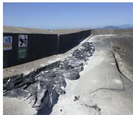
土のうによる応急対策（八代市）
