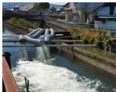
用水路への水の補給（八代市）
