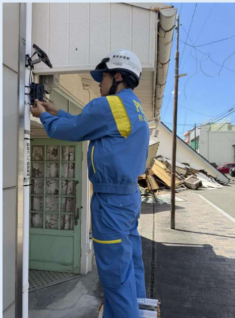
被災地への防犯カメラの設置
