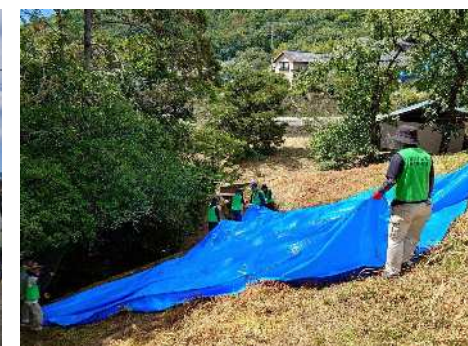
ブルーシート養生
