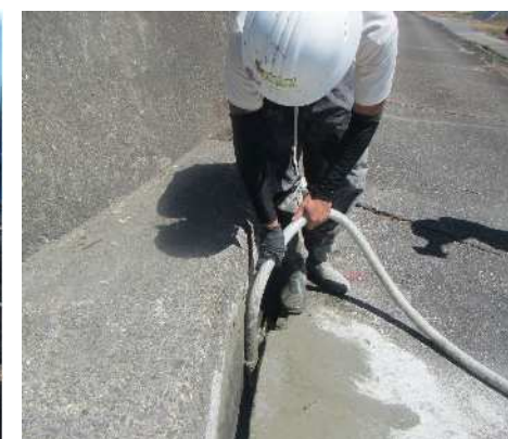
波返工空洞箇所へのグラウト注入
