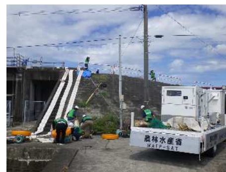
排水ポンプ車配備
