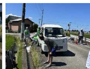
通水状況確認
