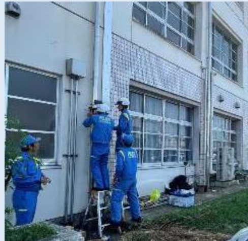
被災地への防犯カメラの設置
