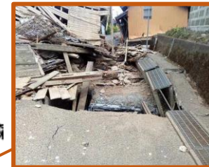
↑幹線水路の沈下 （氷川町）
