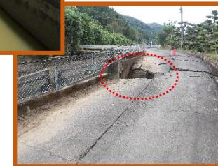
不知火幹線水路の 崩壊（八代市）
