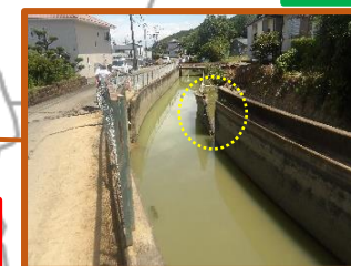
不知火幹線水路の 崩壊（八代市）
