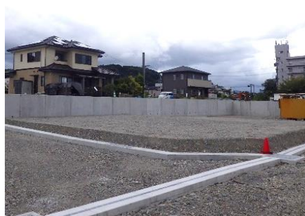
▲宅地造成工事(青井地区)
