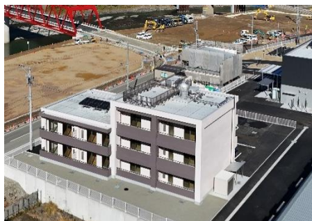
▲災害公営住宅(八代市坂本団地)
