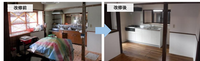
▲空き家改修の様子
