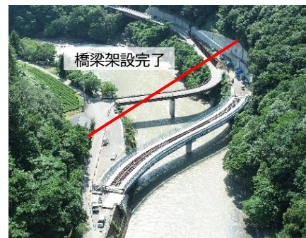
▲国道445号の改良(五木村)
