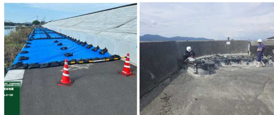
ブルーシート養生
