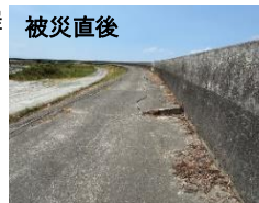
舗装の損傷
