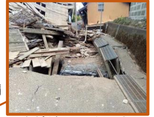
↑幹線用水路の沈下 (氷川町)
