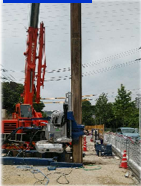
矢板打込工事
