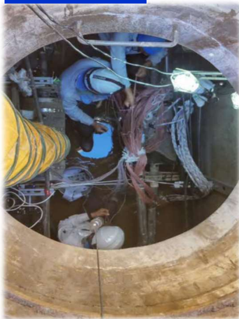
復旧MH対処
