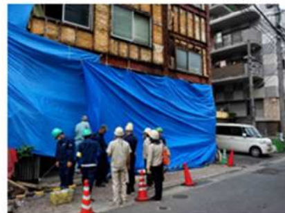
ビニールシートによる石綿飛散防止措置
