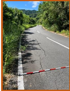
←不知火中腹 基幹農道の亀裂 (宇城市)
