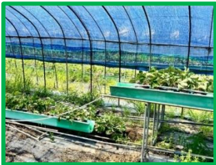
↑イチゴ高設育苗の破損 (八代市)
