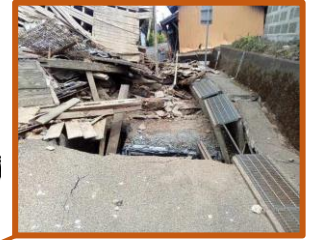
↑幹線用水路の沈下 (氷川町)
