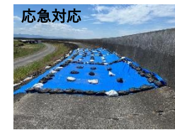
応急対応 ブルーシートの設置
