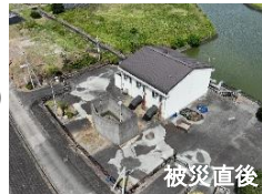
被災直後 液状化の発生
