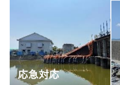
応急対応 応急ポンプの設置
