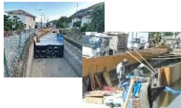
被災により側壁が沈んだ箇所にバイパス管とコンクリートを施工し、通水を確保しています。
