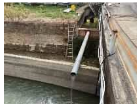
水路に隣接する山の沢水を直接用水路に引き込んでいます。
