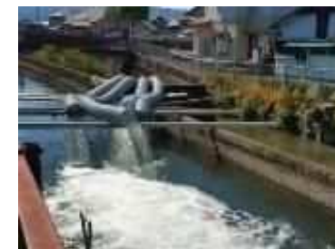
用水路へポンプアップし、排水路の水の再利用に取り組んでいます。
