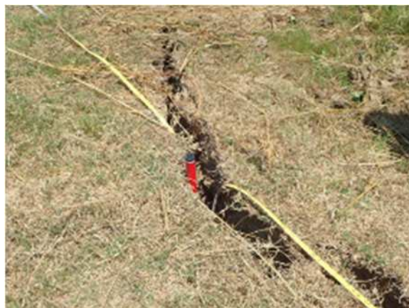
ため池被災状況（クラック）
