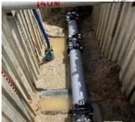
施工後（破損したパイプラインを修繕）
