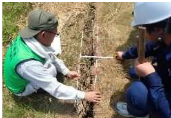
ため池点検調査支援
