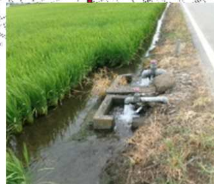
通水再開により農地に水が届く様子
