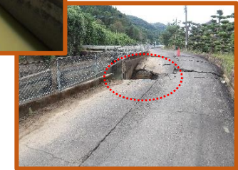
不知火幹線水路の 崩壊 (八代市)
