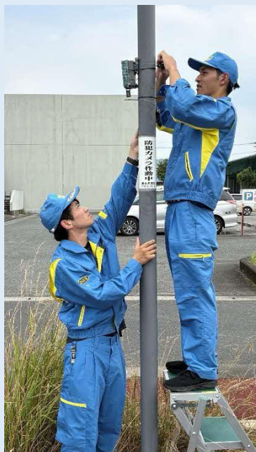
被災地への防犯カメラの設置
