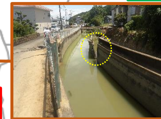
不知火幹線水路の 崩壊 (八代市)
