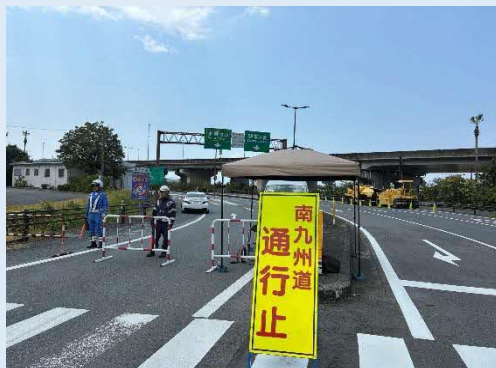
広域緊急援助隊による高速道路での活動
