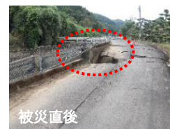
不知火幹線 水路通水試 験状況 (八代市)
