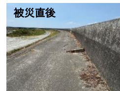
舗装の損傷
