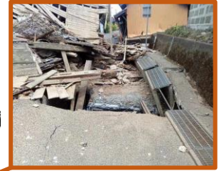
↑幹線用水路の沈下 (氷川町)
