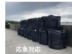
大型土のうの設置
