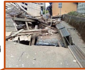
↑幹線用水路の沈下 (氷川町)
