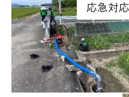
幹線用水路の試験通水状況 (氷川町)
