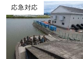
応急ポンプの設置
