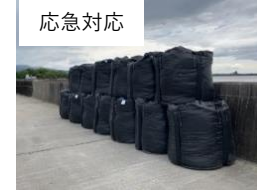
大型土のうの設置
