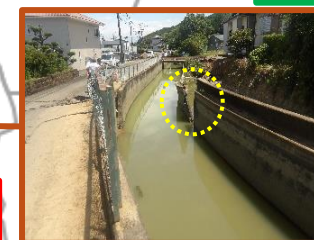
不知火幹線水路の 崩壊 (八代市)
