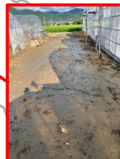
←花きハウスの 液状化 (八代市)
