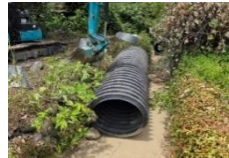
幹線用水路 応急工事状況 (氷川町)
