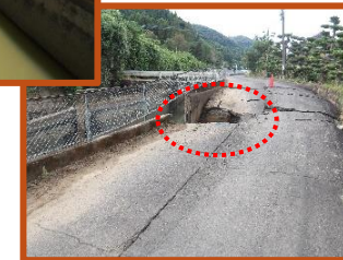
不知火幹線水路の 崩壊 (八代市)
