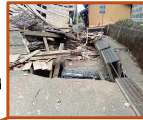
↑幹線用水路の沈下 (氷川町)
