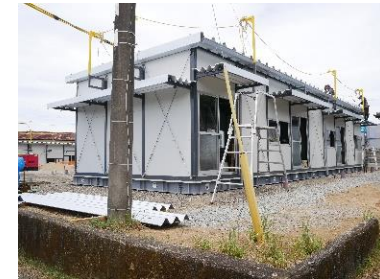
氷川町吉本団地（軽量鉄骨造・平屋）現場状況写真
