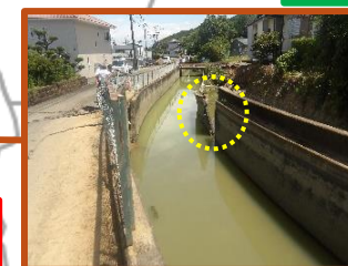
不知火幹線水路の 崩壊 (八代市)
