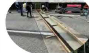
遊間部コンクリート打設
