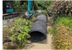
幹線用水路 応急工事状況 (氷川町)
