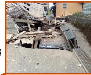
↑幹線用水路の沈下 （氷川町）
