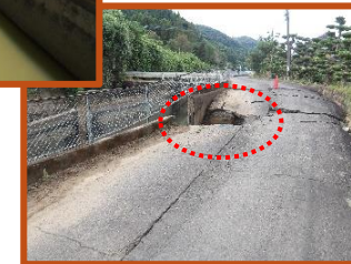
不知火幹線水路の 崩壊（八代市）
