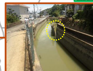
不知火幹線水路の 崩壊（八代市）
