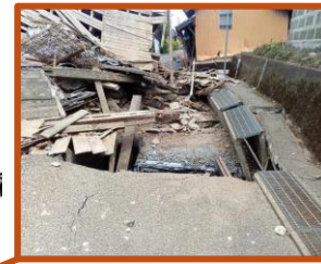
↑幹線用水路の沈下 (氷川町)
