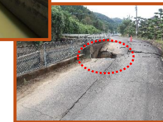
不知火幹線水路の 崩壊（八代市）
