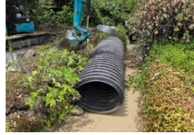
幹線用水路 応急工事状況 (氷川町)
