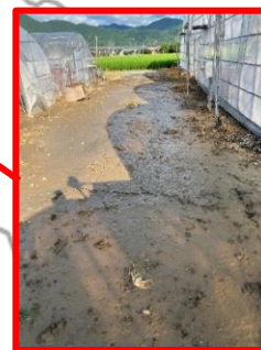
←花きハウスの 液状化 (八代市)
