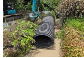
幹線用水路 応急工事状況 (氷川町)
