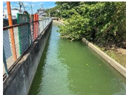
不知火幹線水路 通水試験状況 (八代市)
