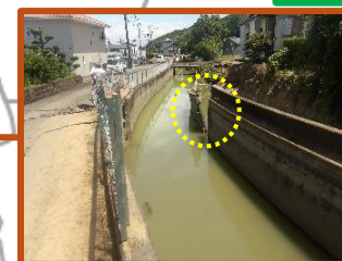
不知火幹線水路の 崩壊 (八代市)
