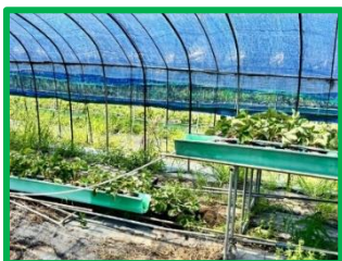
↑イチゴ高設育苗の破損 (八代市)
