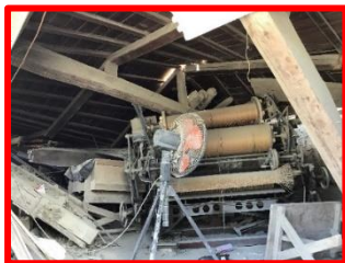
↑いぐさ製織作業場の倒壊 (八代市)
