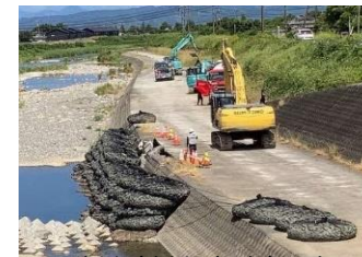
氷川（氷川町）応急工事
