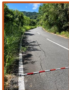
←不知火中腹 基幹農道の亀裂 (宇城市)
