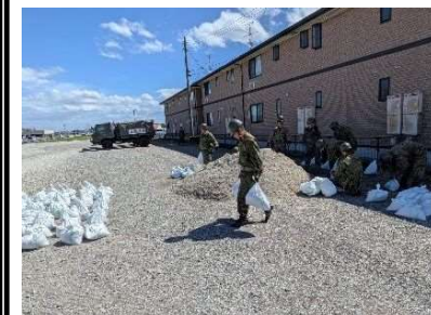
【八代市】ブルーシートを固定する土のうを作成する陸自隊員
