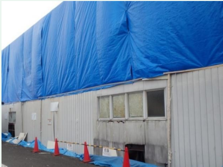
飛散防止措置の例(シート養生)
