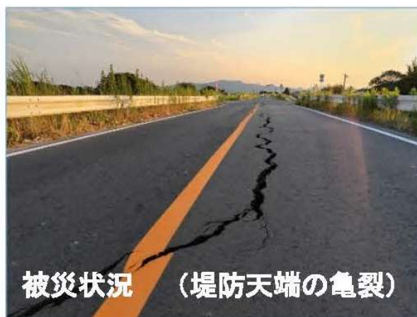
(緑川 右岸8k800m付近:熊本市)
