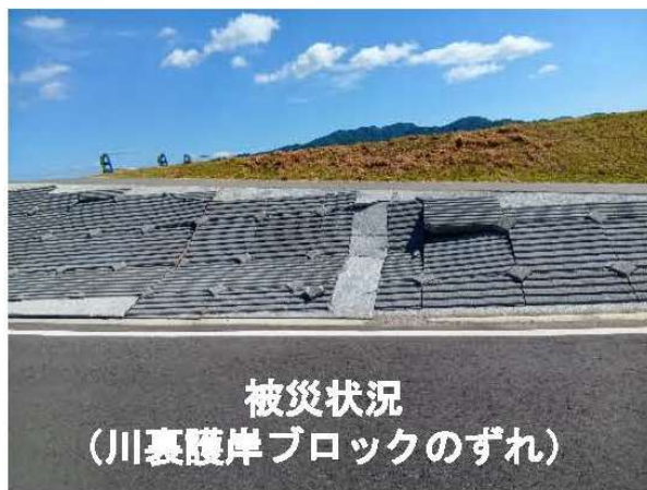
(緑川 右岸2k000m付近:熊本市)
