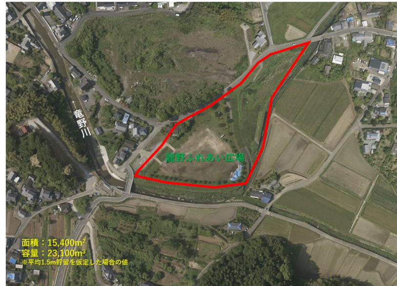
龍野ふれあい広場雨水貯留浸透施設
