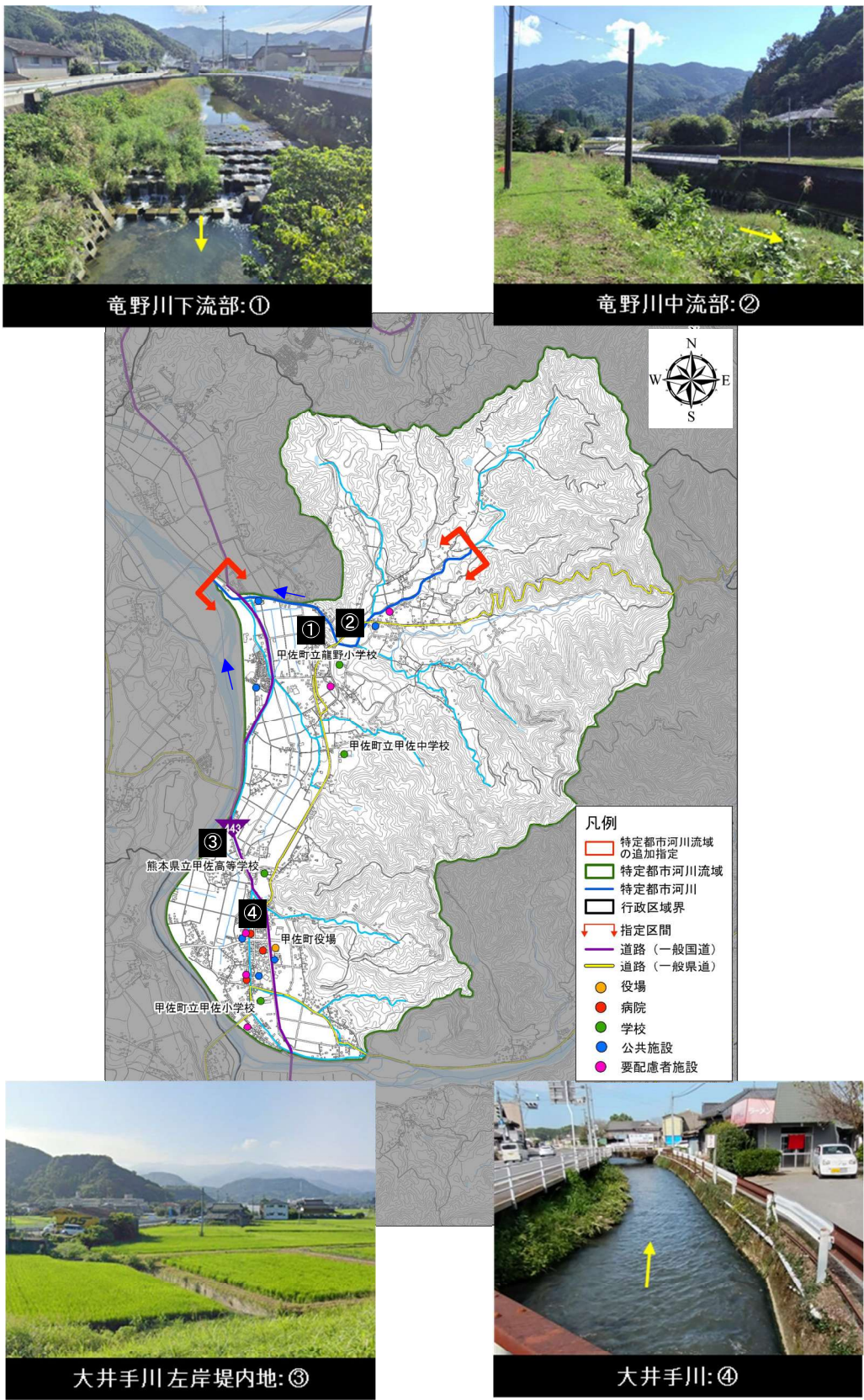
図 1-16 竜野川流域内河川の状況
