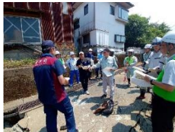
幹線用水路工事打合せ状況 (氷川町)
