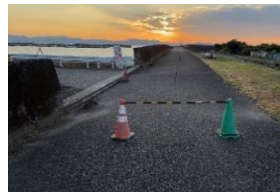
日奈久海岸通行止め (八代市)
