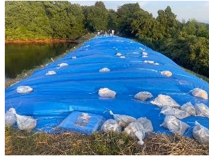
猫迫ため池 ブルーシート設置 (宇城市)
