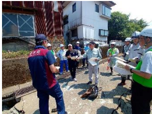
幹線用水路工事打合せ状況 (氷川町)
