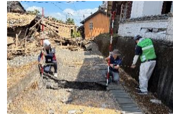
幹線用水路測量状況 (氷川町)
