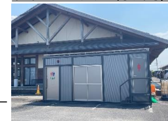
トイレコンテナ（氷川町）
