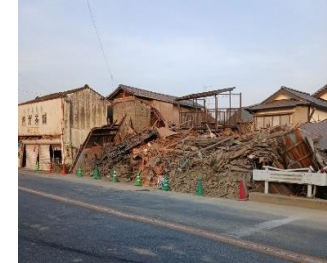
八代鏡宇土線（八代市） 倒壊建築物
