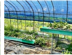
イチゴ高設育苗の破損（八代市）
