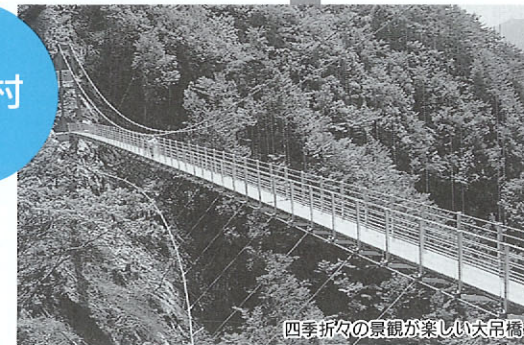
四季折々の景観が美しい大吊橋
