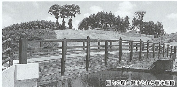
園内の堀に架けられた寛永堀橋
