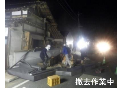
八代鏡宇土線（八代市） 倒壊建築物 撤去作業中
