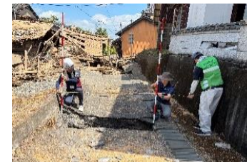
幹線用水路測量状況 (氷川町)
