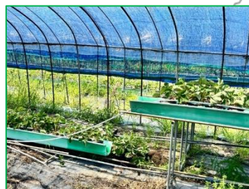
イチゴ高設育苗の破損 (八代市)
