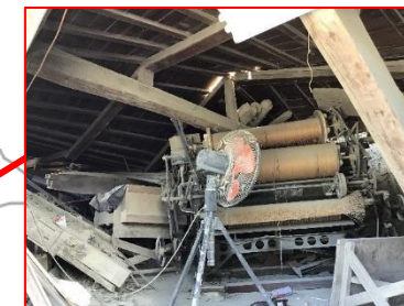
いぐさ製織作業場の倒壊 (八代市)
