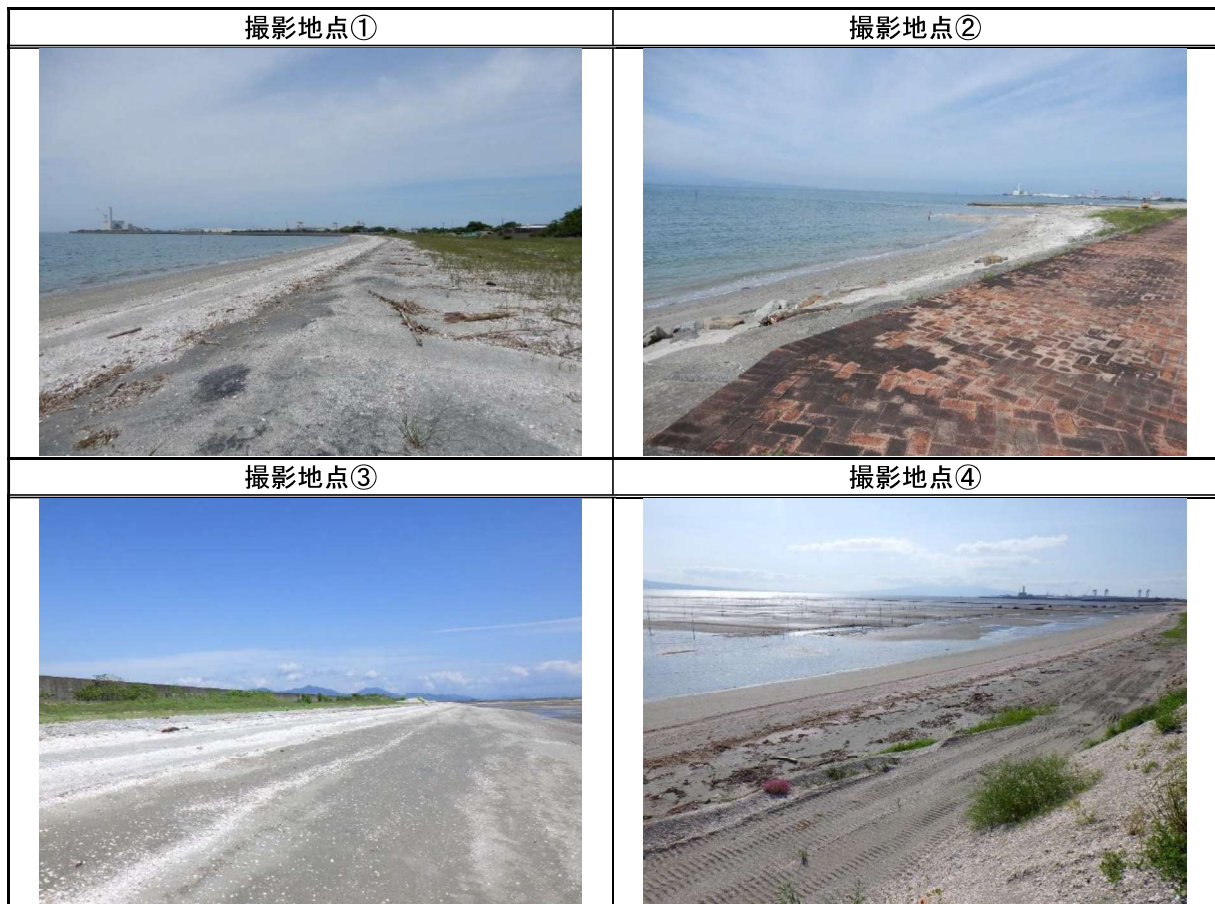
図 7.7-6 砂浜、自然海岸の状況
