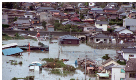
遭风暴潮冲击后的松合地区受灾情况 （原“不知火町”）
