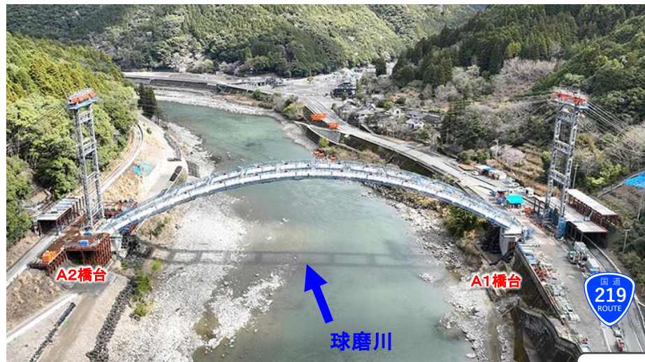
R8.3 上部工(アーチ部閉合完了)
