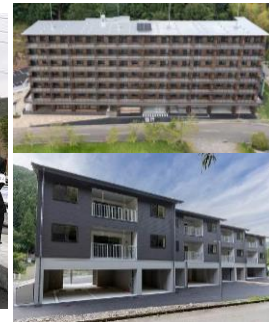
災害公営住宅
