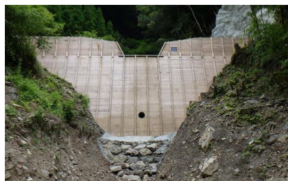
■治山ダム設置状況
