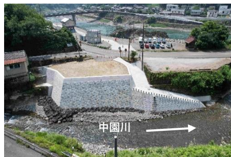
中園川 現場状況(R7.7)
