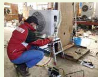
エアコン実習
