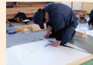
原寸図作成作業
