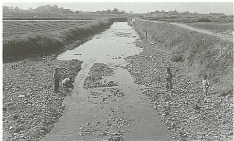
▼改修前の幸野溝
