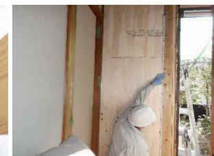
壁の補強(合板)
