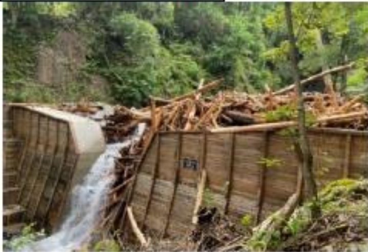
流木捕捉式治山ダムが流木や土砂を捕捉し、下流への流出を抑制（熊本県球磨村）
