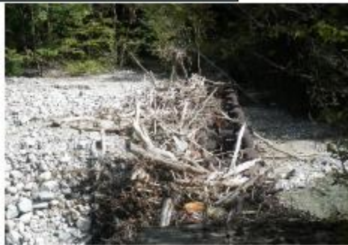
流木捕捉式治山ダムが流木を捕捉し、下流への流出を抑制（岐阜県中津川市）
