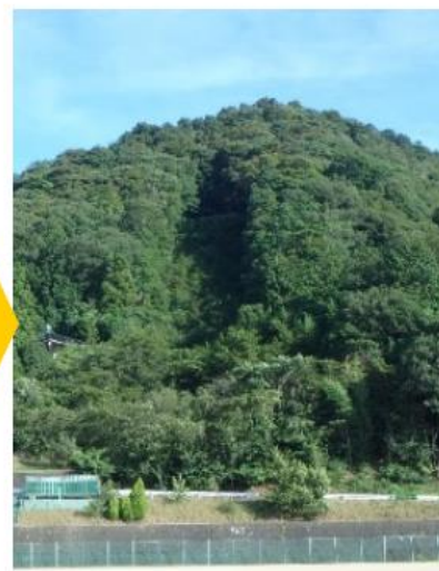
施工後から14年後
