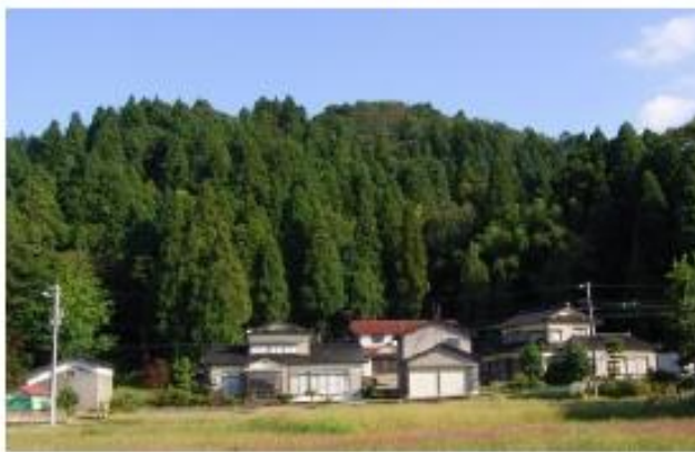
●土砂崩壊防備保安林 林地の崩壊を防止し、家屋・農地・道路等を保護
