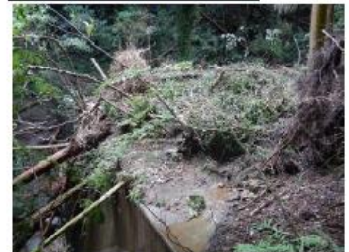
治山ダムが土砂・流木を捕捉し、下流への流出を抑制（群馬県安中市）
