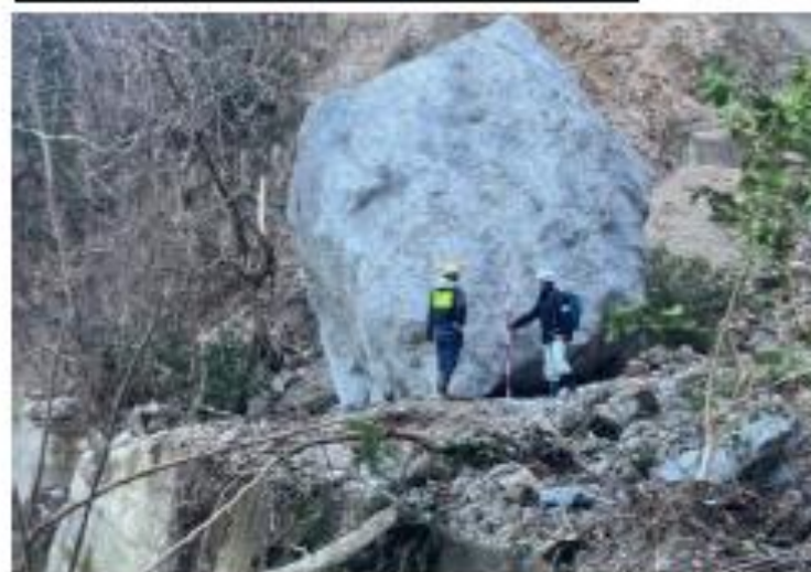
治山ダムが巨石・土砂を捕捉し、下流への流出を抑制（石川県輪島市）
