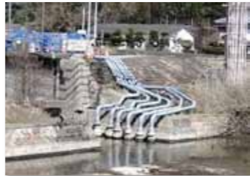
応急ポンプの設置
