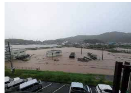
排水機場浸水（上天草市）
