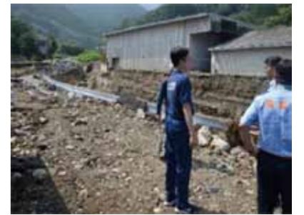
越水土砂流出被害（美里町）
