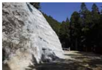
復旧した林道法面
