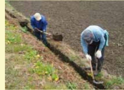
水路の泥上げ
